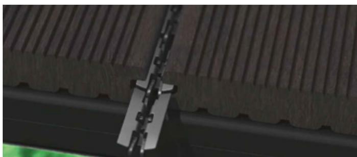
ou simplement les placer devant la lame sur la semelle inférieure et y glisser la lame suivante.
