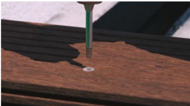
Die versteckte Befestigung in der Nut ist auch möglich. Dazu zwei System49 Start-/ Endclips doppelt übereinanderlegen, in die außen liegende Nut der Diele schieben und mit einer Schraube auf der UK befestigen.
